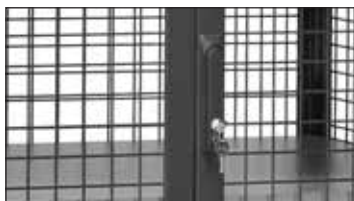
Spanjoletsluiting met zwenkhandel en cilinderslot.
